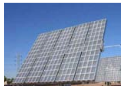
内蒙古 Inner Mongolia, 1MWp 聚光太阳能, 太阳能跟踪系统, 市电并网 CPV Solar System, Tracking System & Grid-Tied 2015 年 11 月建成 Completion Year: November, 2015
