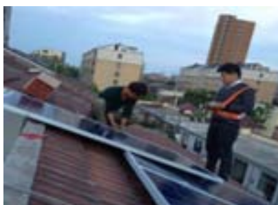
南京 Nanking, 20KWp 大楼平台固定, 与市电互补示范 Roof-Mounted & Grid-Tied 2015 年 02 月建成 Completion Year: February, 2015
